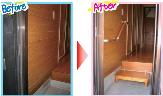
段差昇降の動作にあわせて手すりを取り付けました。段差にあわせて角度をつけたことで、より安全に使用できます。
