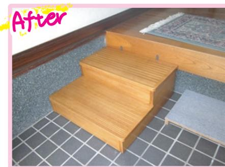
2段の木製階段を設置し段差を解消しました。1段あたりの高さは13cmほどなので楽に昇降できます。
