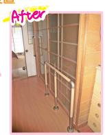
廊下の両側はガラス戸で、手すりを取り付けるための 壁がありません。そこで、ドアの片面(出入りしない側) に床から立ち上げる形で手すりを取り付けました。
