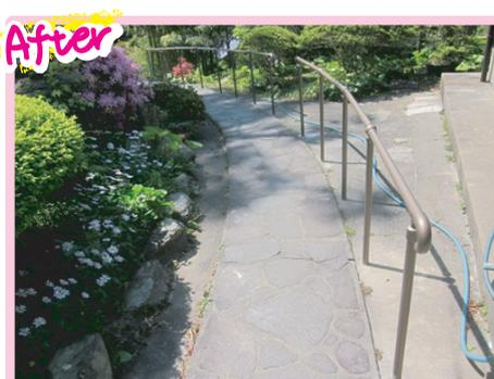
約 12m あるアプローチに、手すりを取り付けました。その先には階段があり、以前に手すりを取り付けられていました。アプローチの手すりは、階段の手すりと途切れることなく使えるよう結合しました。広い庭があり、庭の手入れを娘夫婦がされています。庭への出入りを遮断しない工夫をして仕上げました。
