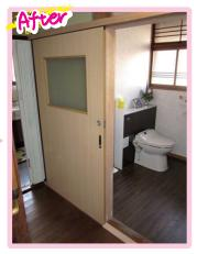
開き戸(ドア)の時は、開閉時にドアの脇に寄ったり、少し さがったりという移動が必要でした。そのため、扉を引き戸 に交換し、開閉時の動きが最小限ですむように改修しました。
