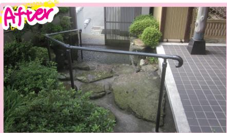
玄関から門扉までには、石の階段があります。階段の形状、高さに合わせて手すりを取り付け、安全に移動できるようにしました。和風のお庭にも違和感がないよう、落ち着いた色の手すりを取り付けました。
