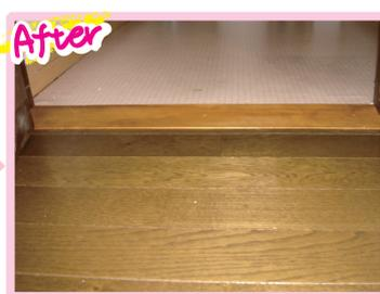
トイレの入り口には敷居段差があり、さらに内開きの大きなドアが障害となり、トイレ内部が狭く動きづらい状況でした。そこで、敷居を撤去してドアを外開きに変更しました。
