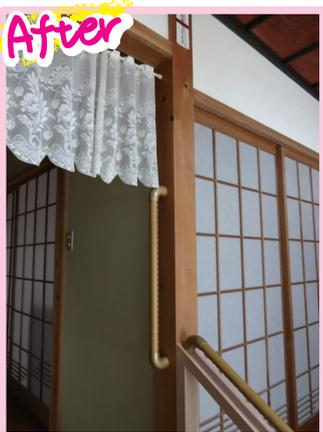
上がりかまちが広いので、中央の柱をいかにして真ん中に手すりを取り付けました。1本の手すりで、廊下側と障子の先にある居間側と両方からの上がり下りに使えます。また、上がりかまちに座って靴の脱ぎ履きを行うため、立ち上がり時の手すりとしても使用。
