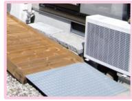
↑ サーモウッドは耐腐性が高い 木材製品ですが、より長く安全に 使用できるよう、地面と接する部 分には縞(しま)鉄板を使用しま した。
