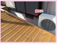
介窓の下にある換気□の機能を 阻害しないため、壁との間に隙間 を設けるとともに素材はコンク リートではなくサーモウッドを選 定しました。
