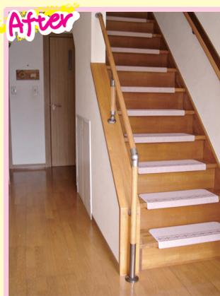
壁がない部分にも金具を使用して手すりを取り付け。
