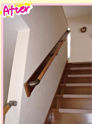
片側には既存の手すりがありました。強度が十分でなく危険な状態でした。そこで補強材を使って安全な手すりを左右に取り付けました。
