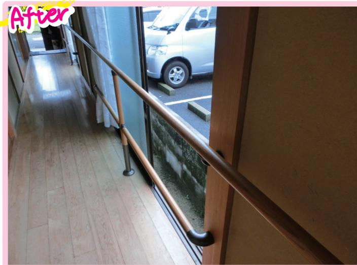
掃き出し窓が並び、壁の部分が少なく、手すりを付けられる場所が限られていました。階段下の狭い通路部分や、段差があることで歩行器での移動が困難なため、窓の前も途切れることなく工夫して手すりを取り付けました。
