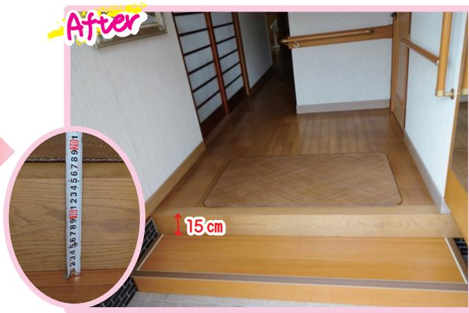
壁を伝いながら移動しており、高さ約 30cm の上り框を上り下りする際、バランスを崩して転倒しそうになっていました。そこで、上り框の半分の高さで、幅の広い木製式台を製作しました。
