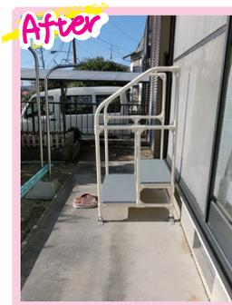
洗濯物を干すために、掃き出し窓から出入りされています。毎日のことなので、40cmもの段差を昇降するのが大変でした。そこで、**両側に手すり**が付いた階段を設置し、段差を解消しました。
