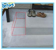
勝手口の扉は開き戸のため、開閉時には1歩下がる動作が必要でした。 ところが外側の階段は幅が狭く、段を踏み外してしまう危険があった ので、階段の幅を拡げて十分なスペースを確保しました。
