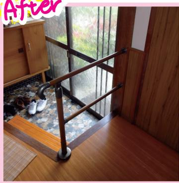
トイレの移動用に付けた手すりは、歩行時に身体を支えるためだけでなく、**転落防止柵**の役割と、玄関上り框の昇降にも使えるよう、形状と手すりの高さを工夫しました。これで安全に移動できます。
