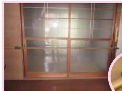
↑ 手すりを設置した状態
