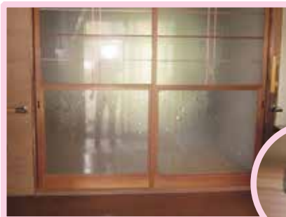
↑ 手すりを外した状態
