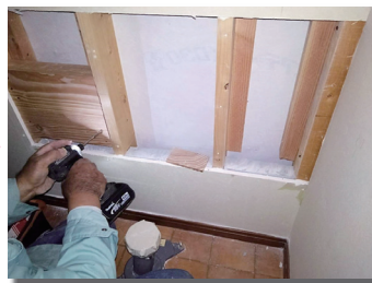
▲ 便器後方の壁を補強します
