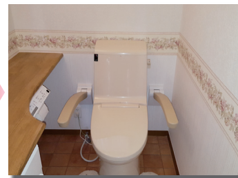
▲ クロスを貼り替えた後に便器を戻し、壁付手すりを取り付けます
